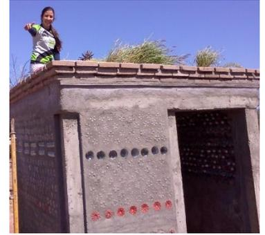
**Las paredes soportan fácilmente una azotea de esas características, pues la disposición horizontal de botellas garantiza una resistencia a la compresión superior a 2 toneladas.**
